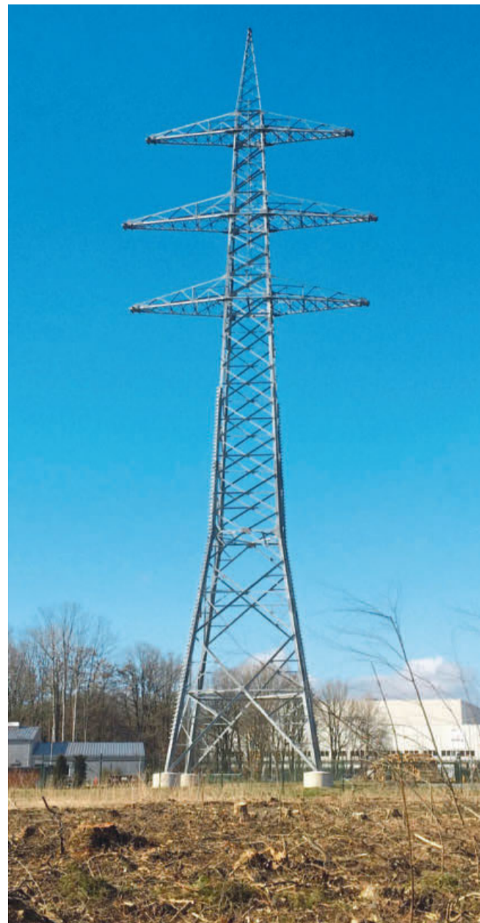
Hohe Masten in Halle (hier der neue bei Storck), tiefe Gräben in Pium: Die Politiker dort wehren sich gegen die Verlegungsmethode, die Amprion für die Erdverkabelung vorschlägt. Foto: Johannes Gerhards
