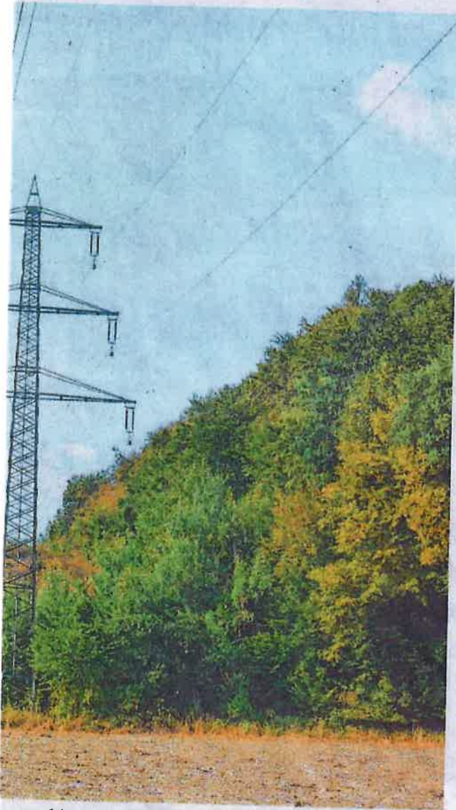
Stromleitung über den Teuto. Hinter dem Kamm liegt das Stadtgebiet in die Erde.
